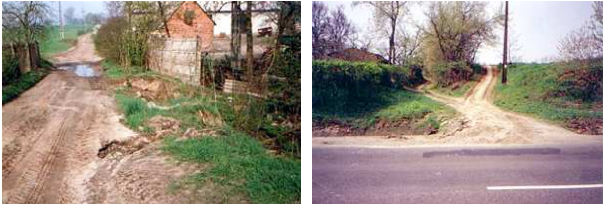
Fot.2. Drogi gruntowe dochodzące ze wzgórza do drogi krajowej nr 83
